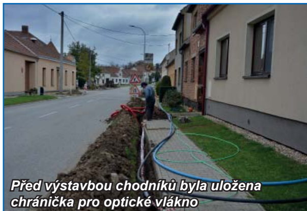
Pokračující práce při výstavbě chodníků - ulice směr Nesovice
