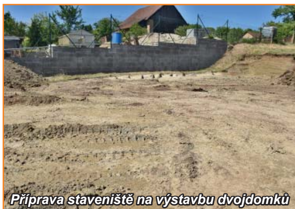
Příprava staveniště na výstavbu dvojdomků
