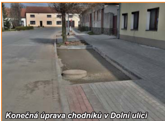
Konečná úprava chodníků v Dolní ulici
