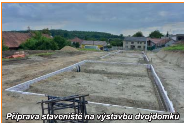
Příprava staveniště na výstavbu dvojdomků
