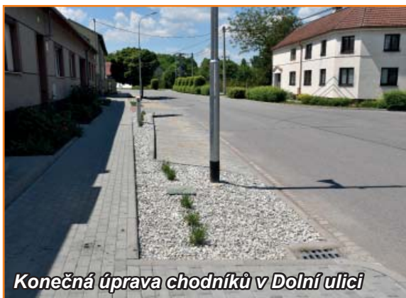
Konečná úprava chodníků v Dolní ulici
