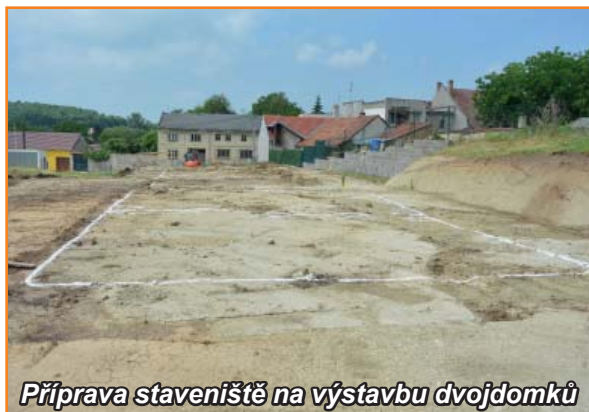
Příprava staveniště na výstavbu dvojdomků
