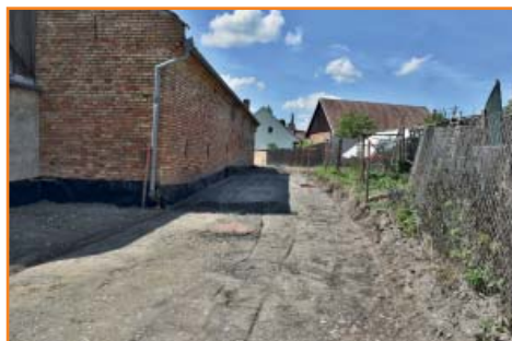
Oprava místní komunikace k přečerpávací stanici Na Flíčku
